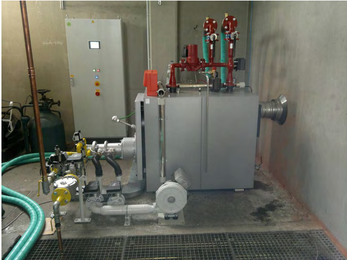
Abbildung 4: FLOX-Kesselanlage für Gase bis min. 25 Vol% CH 4
