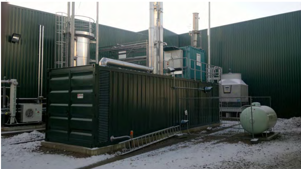
Bild 2: Deponiegasverbrennung Dörpen, bei der Warmwasser zur Beheizung der am Standort errichteten Boxenfermentation von Grüngutabfällen verwendet wird
